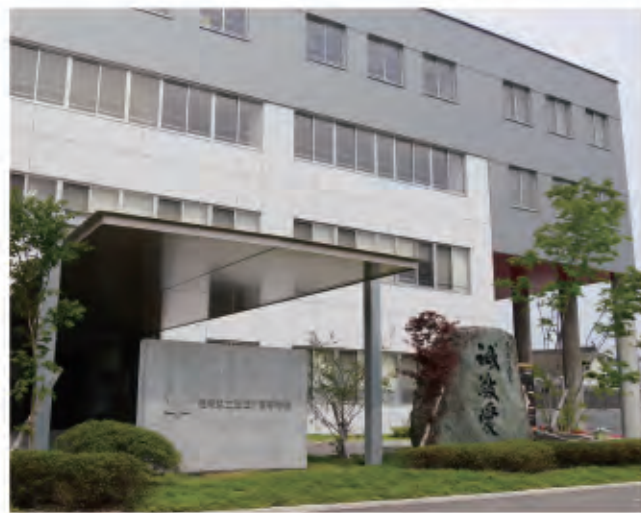
改築が完了した、県立西田川高校
