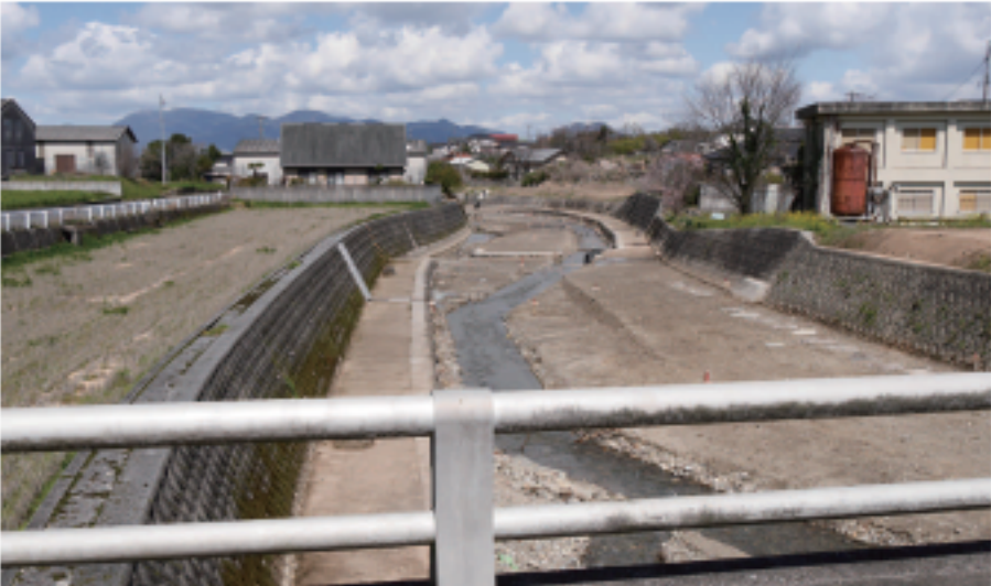
遊歩道の再整備や雑草撤去で綺麗になった猪位金川
