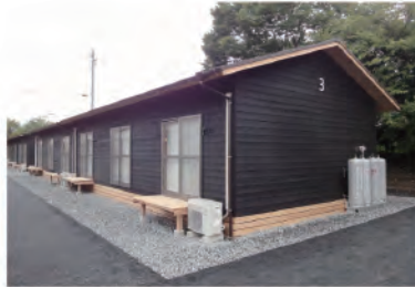
杷木小学校運動場応急仮設住宅
