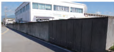
撤去予定の田川保健福祉事務所別館のブロック塀 ブロック塀の撤去を行う予定の県有施設
