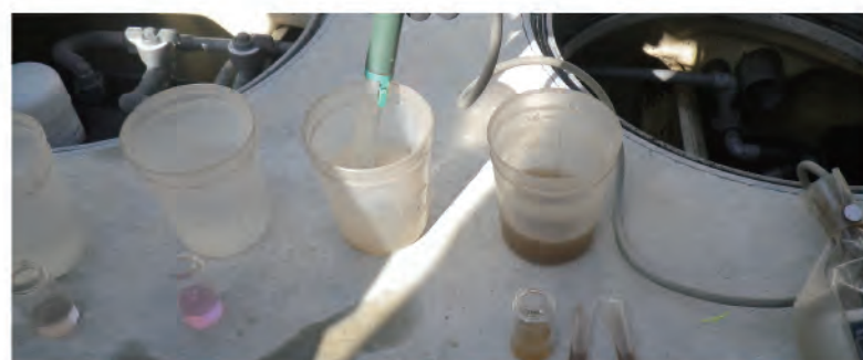
合併浄化槽の清掃・点検をしている様子
